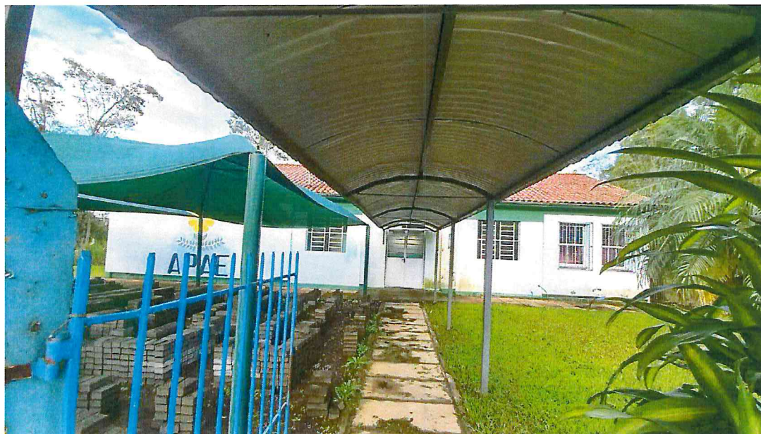
Figura 02 – Imagem da edificação.
