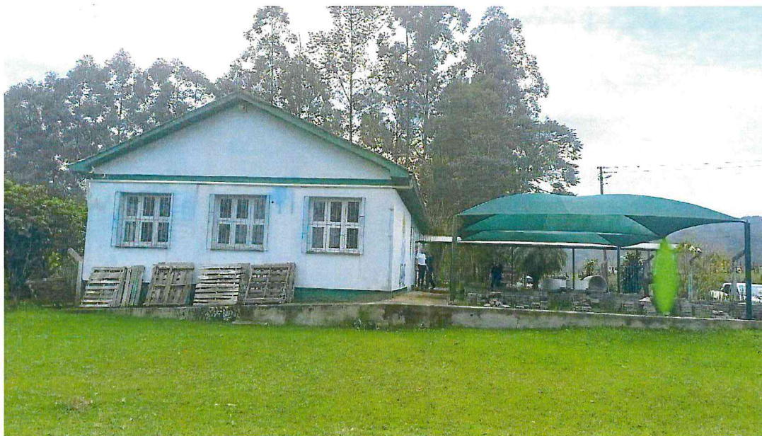
Figura 06 - Lateral da edificação
