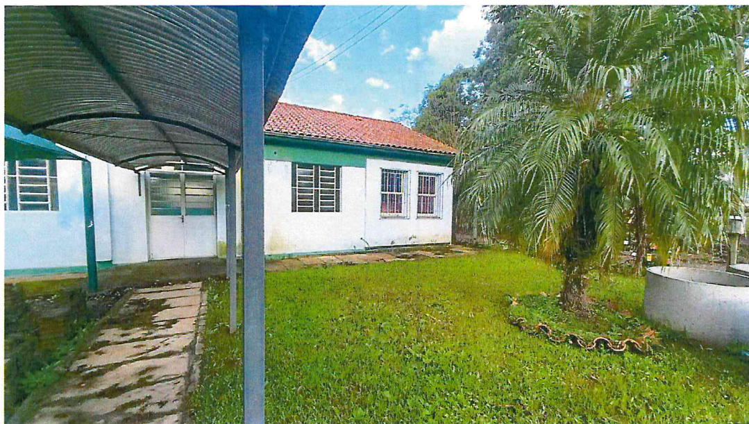
Figura 03 – Imagem da edificação e do pátio.
